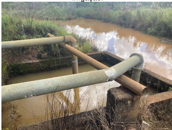
Figura 09: Ponto de captação de água para irrigação.
